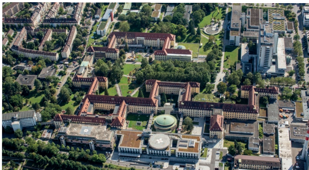
Der zentrale Campus des Universitätsklinikums Freiburg umfasst den Großteil des Gebäudebestands auf insgesamt ca. 550.000 m 2 Brutto-Grundfläche.
