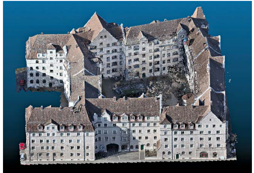
Die mittels Photogrammetrie erstellte 3-dimensionale Punktwolke der erfassten Wohnanlage
